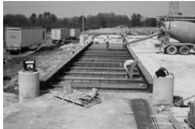
Figure 7-1. Pour Concrete
